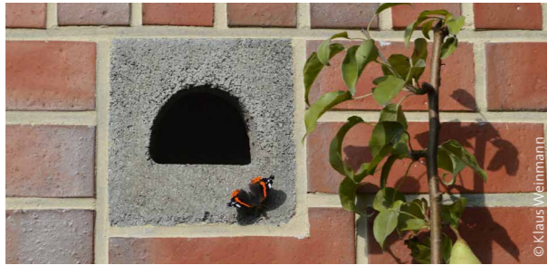
▲ Halbhöhle in Klinkerfassade
