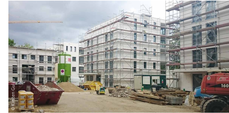
▲ Eingerüstete Gebäude auf Baustelle
